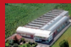
Sede storica produzione gruppi termici Historical headquarters production of burners Via Sile, 32
